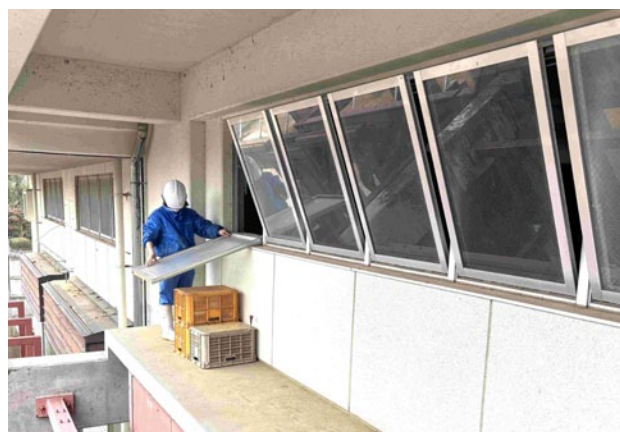
窓に緩衝材シートを設置中
