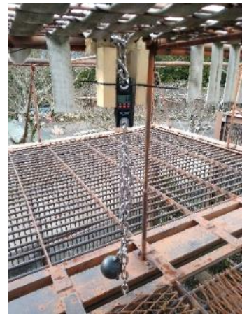
写真9 天井上部の吊り量り
